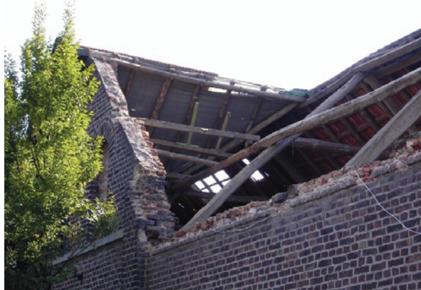
FIG. 3: Strong tornado damage (T5/F2 – 220-254 km/h); upper part: 29.06.1997 - Bissendorf / Germany (Photo: Martin Hubrig), lower part: 18.07.2004 - Tönisvorst / Germany (Photo: Thomas Sävert).
